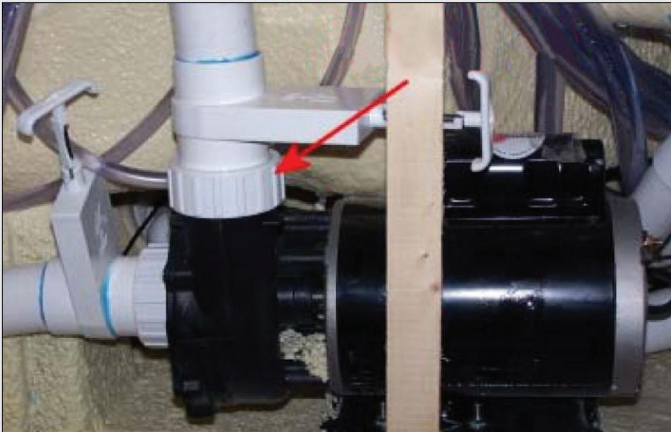
FIGURE 1.5 : PUMP UNION; LOOSEN UP TO BLEED AIR
