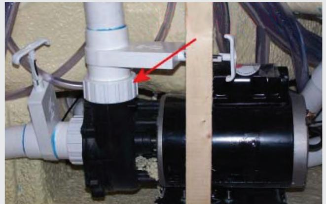
FIGURE 1.9b : PUMP UNION; LOOSEN UP TO BLEED AIR
